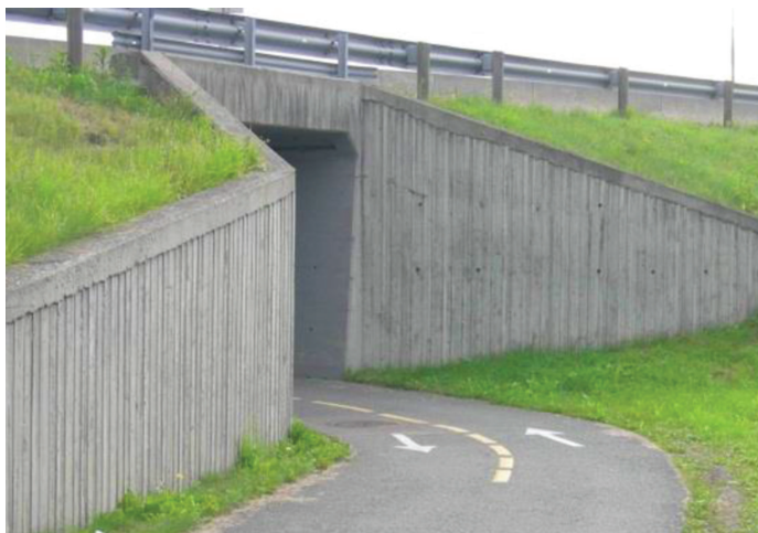
Figur 3.8: Eksempel på bruk av gul midtlinje på gang- og sykkelveg ved undergang med dårlige siktforhold
