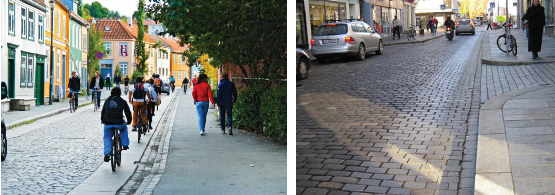
Figur 3.14: Spesiell steinsetting langs sykkelrute med heller eller saget brostein
