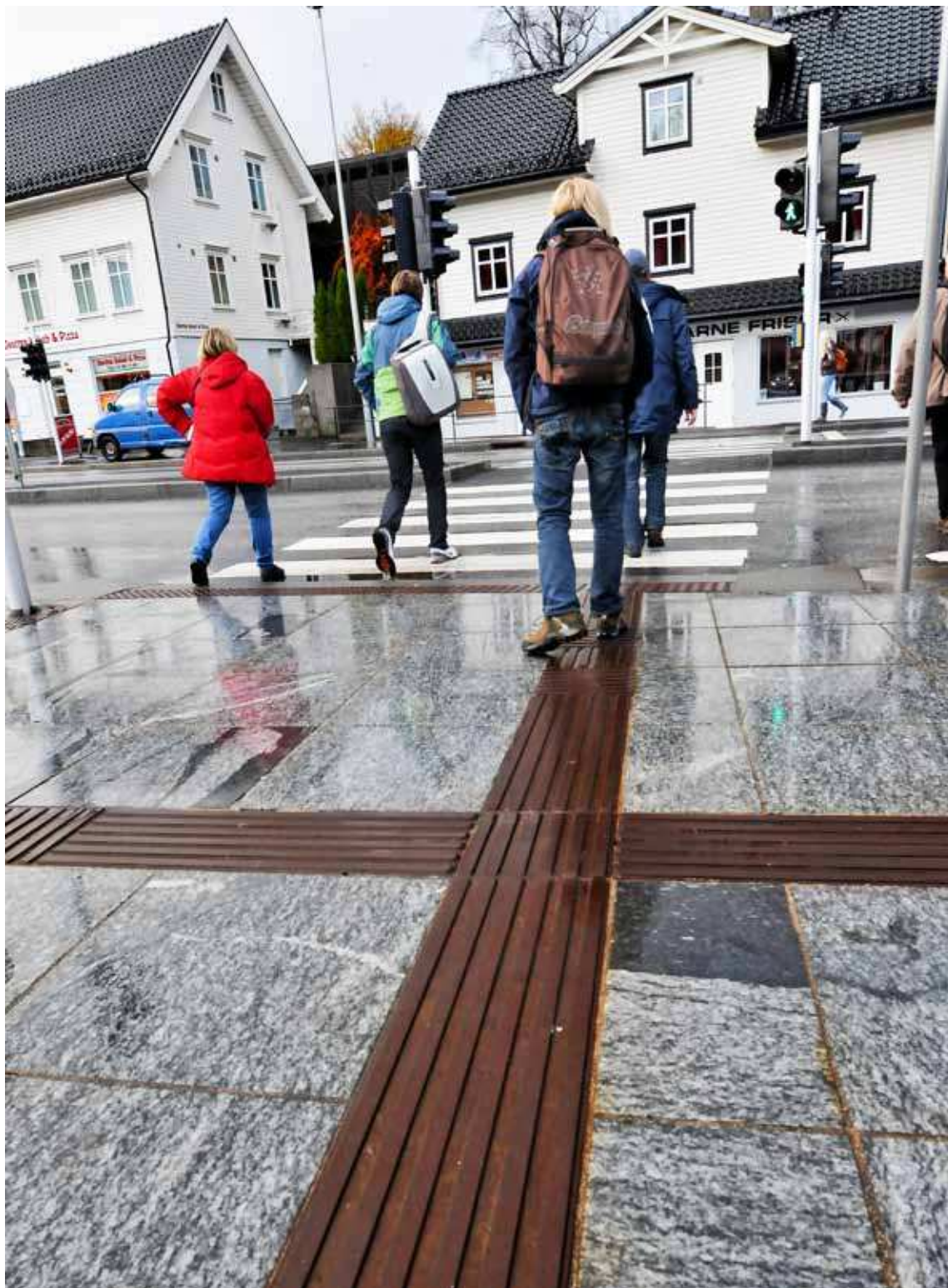
Kunstige ledelinjer i støpejern. Kontrasten er god mot øvrig gategrunn og retningsindikatoren har en bredde på 30 cm, noe som er i henhold til anbefalingene. Retningsindikatoren anbefales imidlertid lagt inn mot midten av varsselfeltet foran gangfeltet, og det burde vært lagt oppmerksomhetsfelt inn mot retningsendringen. Foto: Knut Opeide.
