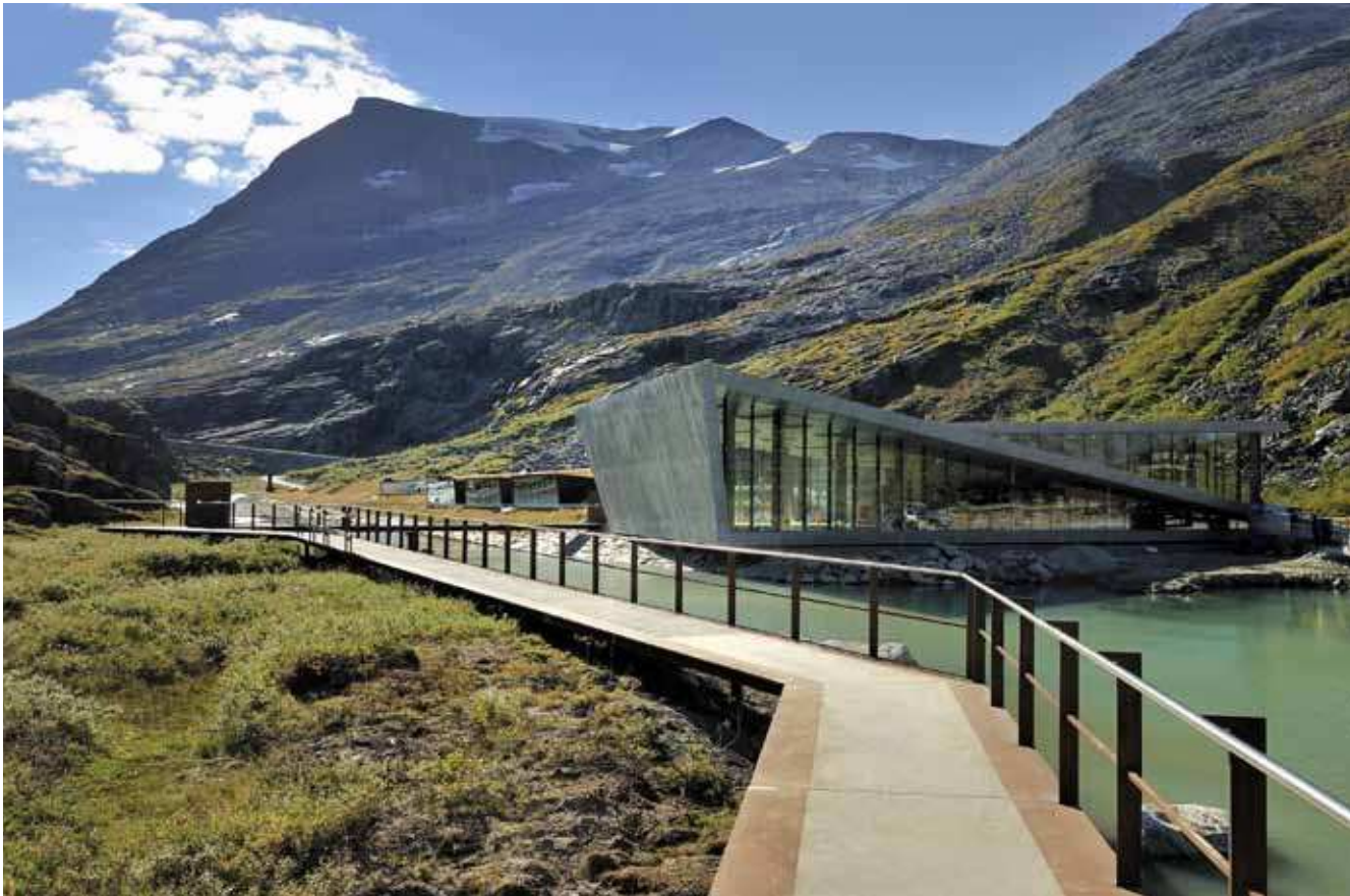
Severdighet med universell utforming. Nasjonal Turistveg, Trollstigen. Rampe/gangbro sikrer trinnfri atkomst mellom servicebygg og utsiktspunkt. Rampen har rekkverk og kontrastfarge mot omliggende natur. Foto: Jarle Wæhler/Statens vegvesen.
