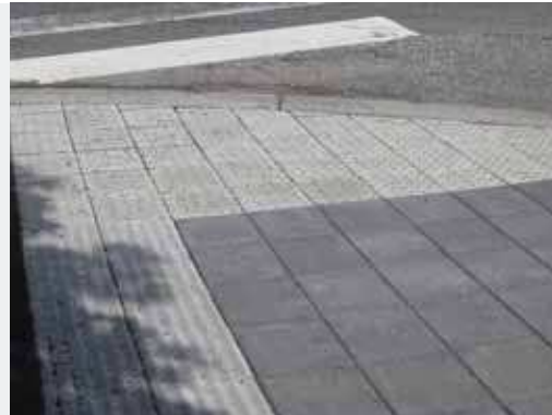
Tønsberg sentrum. Varselfeltet og oppmerksomhetsfeltet ligger vinkelrett på gangfeltet til tross for den krappe kurven. Oppmerksomhetsfeltet er lagt til siden for å treffe den indre fortaukanten. Foto: Ole Th. Bommen, Asplan Viak.
