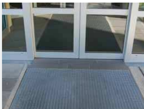
Skaperist fungerer som et naturlig oppmerksomhetsfelt foran en butikkinnang. En slik metallrist gir auditiv kontrast og er et godt ledeelement. Foto: Elin Katrine Nilsen.
