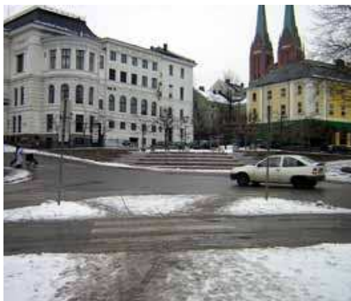
Skien sentrum. Kryss med fotgjengeroverganger i spesielle vink-ler, gir store utfordringer for synshemmede. Det er lett å havne midt ute i krysset, når ikke trafikkøer er markert og rekkverk/ledegjerde mangler.
