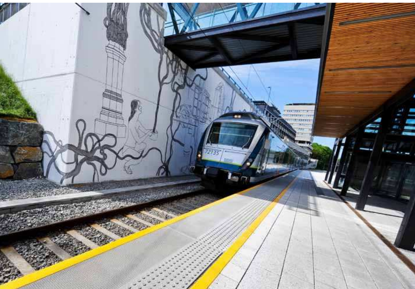
Tydelig markering av plattformkant, både visuelt og taktilt. Foto: Knut Opeide.
