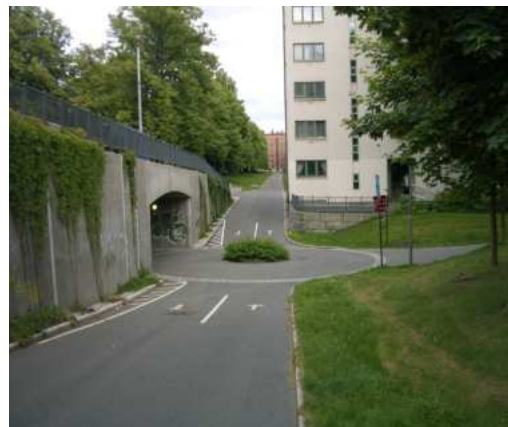
Chr. Michelsens gate, Oslo. Bred undergang med rundkjøring og adskilte kjøreretninger for syklist. I selve undergangen er arealet for fotgjengere og syklist adskilt. Foto: Finn Aslaksen.
