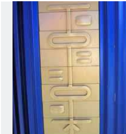
Oslo, Stortingsgata. Taktil angivelse av gatekryssing på boksen på signalanlegget. Foto: Elin Katrine Nilsen.
