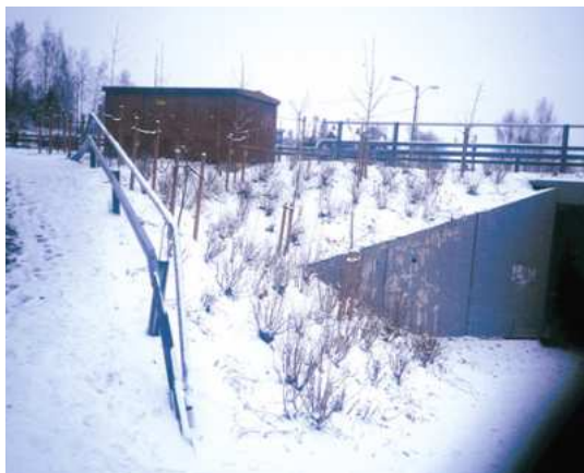
Hagan, Nittedal. Typisk undergang – for bratt for mange bevegelseshemmede. Foto: Finn Aslaksen.
