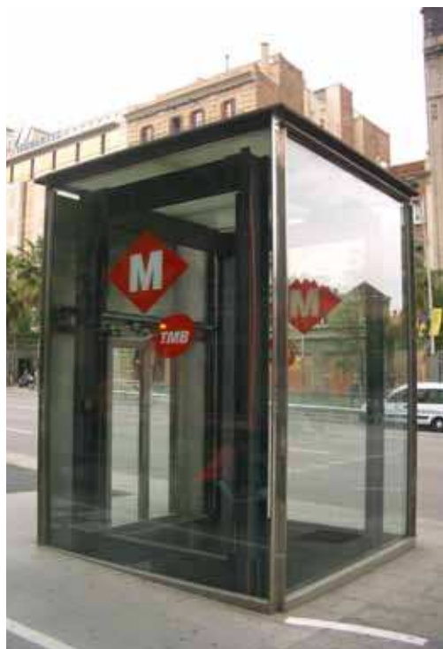
Barcelona, Spania. En godt markert heis blir en del av kollektivsystemets grafiske profil og gjør kollektivtrafikken synlig i gatebildet, også når den går under gateplan. Foto: Finn Aslaksen.
