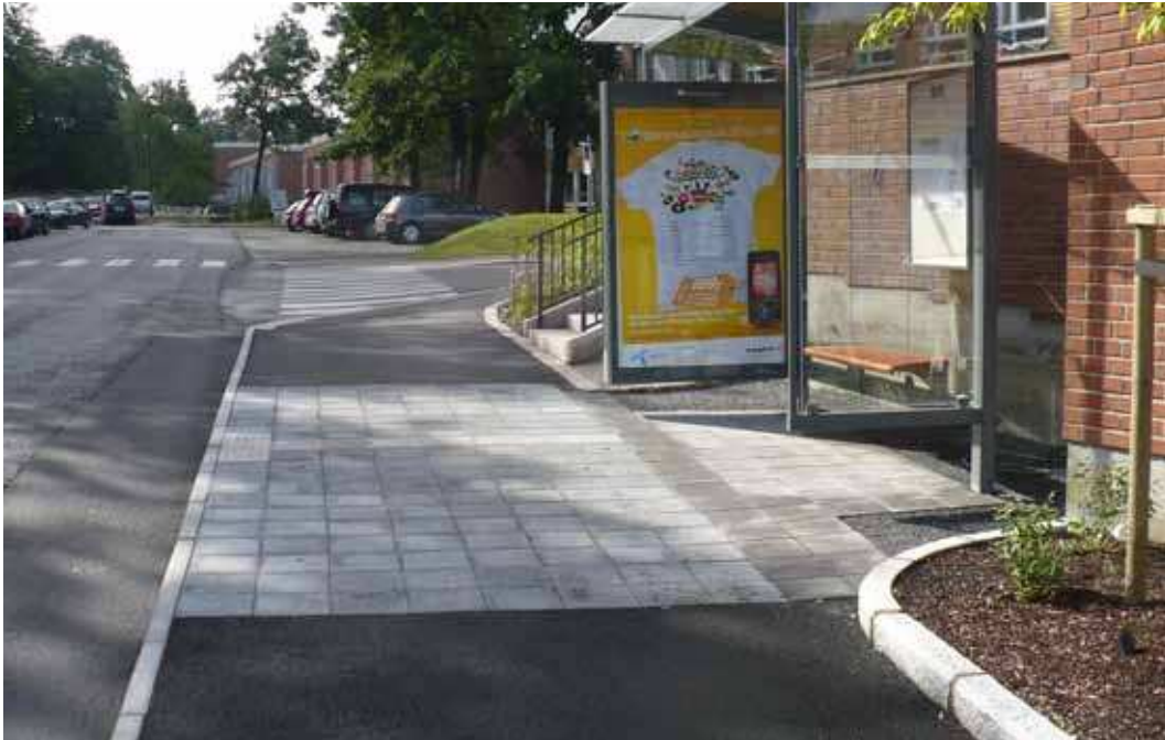
Holdeplass ved Porsgrunn sykehus. Holdeplassen er lett å finne og den er lett å se for de kjørende. Det er gode naturlige ledelinjer fram til holdeplassen. På selve holdeplassen er det i tillegg kunstige ledelinjer, men disse burde ha hatt større kontrast i forhold til de andre hellene på selve holdeplassen. Foto: Ragnar Grøsfjeld.
