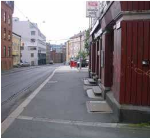
Pilestredet, Oslo. En vanlig situasjon med trappeutspring og lave kanter inne ved veggen som kan gi snublefare. Her burde det ha vært en veggsoner. Vannrennen i forgrunnen er et eksempel på en løsning som er lett å passere med rullestol og rullator.
