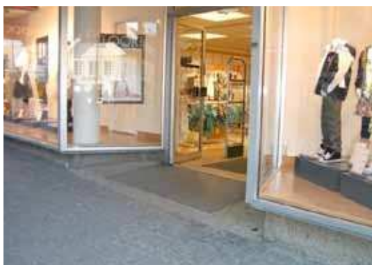
L'Estartit, Spania. Nedsenket inngang fra gågate. Foto: Finn Aslaksen.
