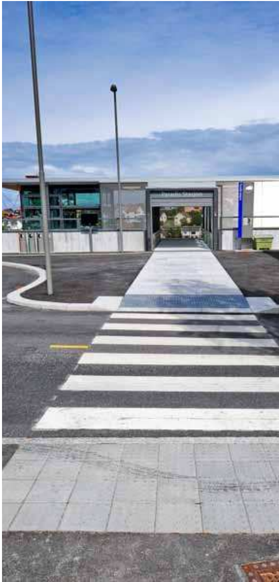
Tydlig markering av gangfelt. Kunstige ledelinjer utgjør et varselfelt i tilstrekkelig dybde, nedsenket kantstein og variasjoner i bruk av belegning, gjør det enkelt å finne krysningspunktet og krysse vegen. Foto: Knut Opeide.
